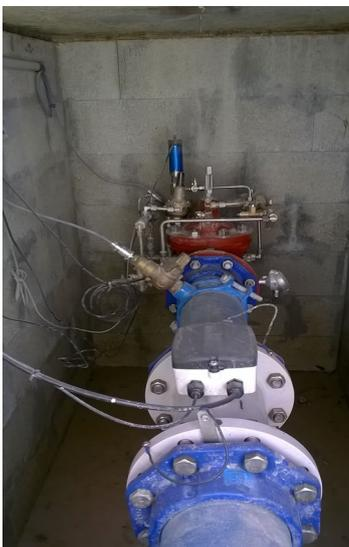
Il est préconisé d'installer une boîte à boues en amont des vannes et des équipements de modulation de pression afin de les protéger des particules pouvant se retrouver dans les réseaux.
