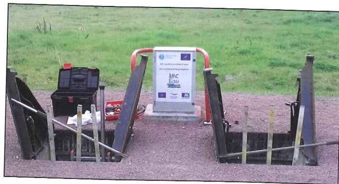
Source : Syndicat intercommunal d'alimentation en eau potable (SIAEP) du Blayais. Figure 4. Regard pour l'emplacement des modulateurs de pression dans le cadre du projet MAC Eau
