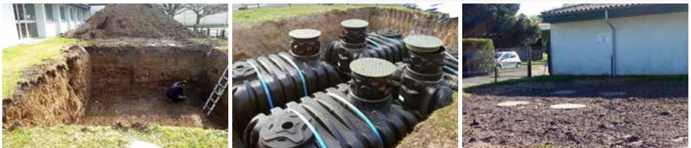
Photos de l'installation de 4 cuves enterrées pour une capacité totale de 20m<sup>3</sup> sur le terrain de l'école de la commune de Salleboeuf.
